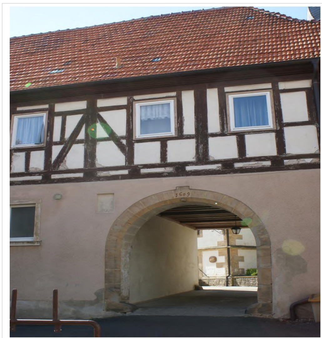
Schule im Torbogenhaus erbaut 1609
